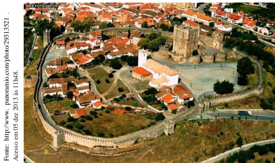
Figura 28: Vista aérea do Castelo de Bragança e a vila murada
