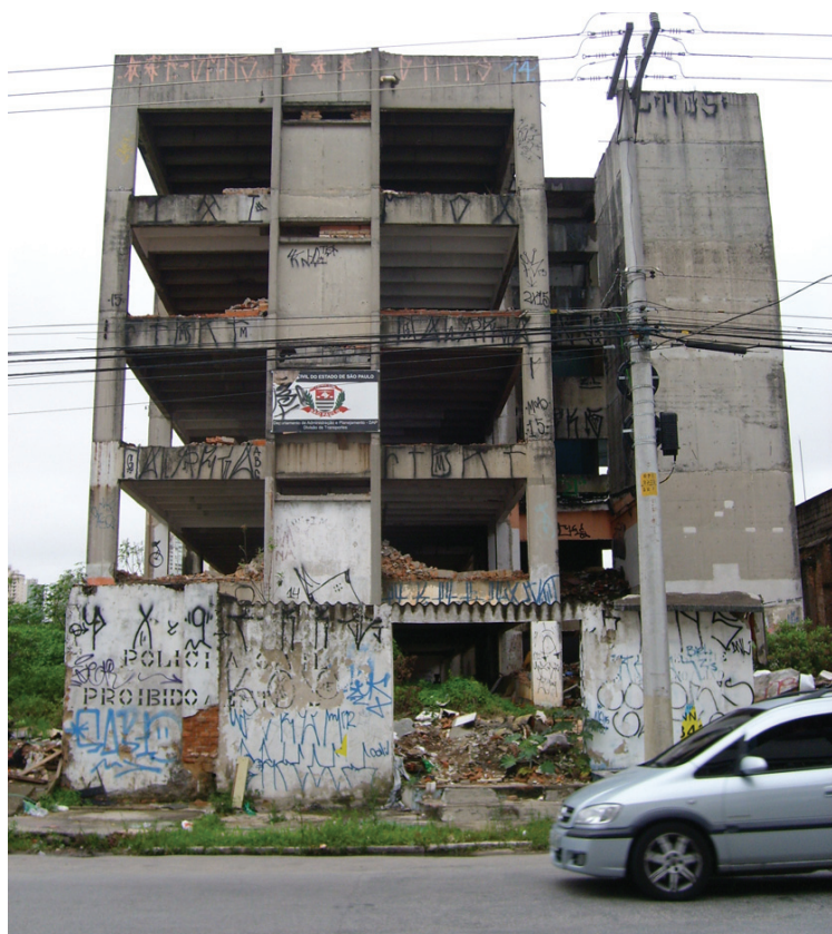
Figura 13 – Estrutura do prédio da Polícia Civil aonde localizava-se a Favela Presidente Wilson II Fonte: Próprio autor, 2015.
