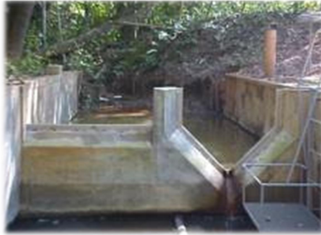
Vertedor retangular e triangular.
