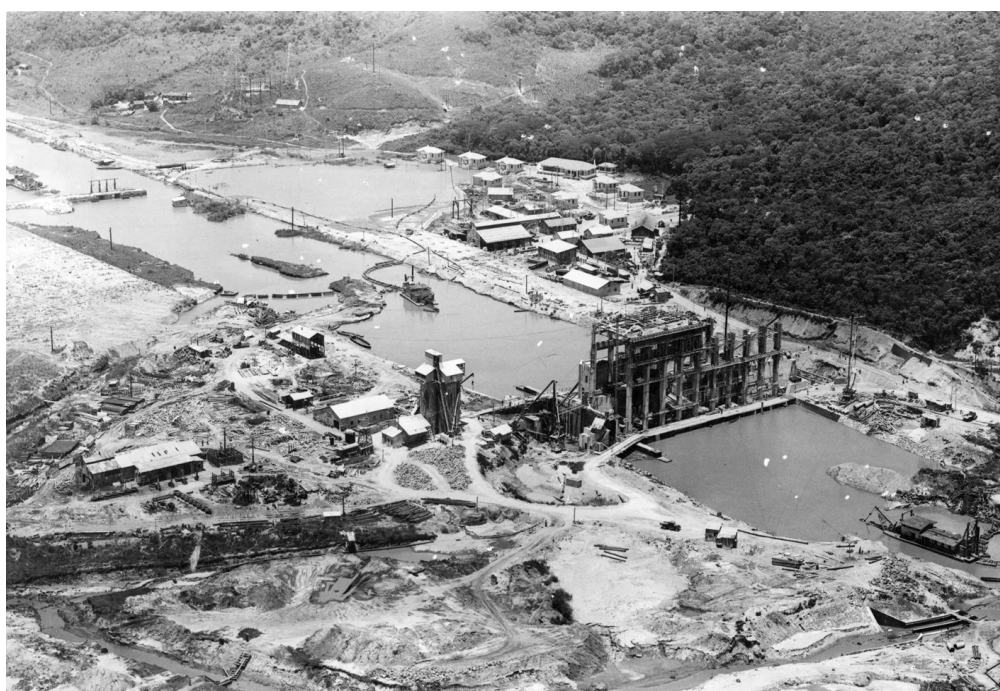
Figura 2 - Construção da Usina Elevatória de Traição (em meados dos anos 40)
