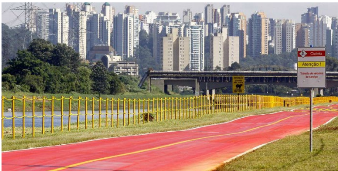
Figura 17 - Ciclovía Marginal Pinheiros e prédios ao fundo
