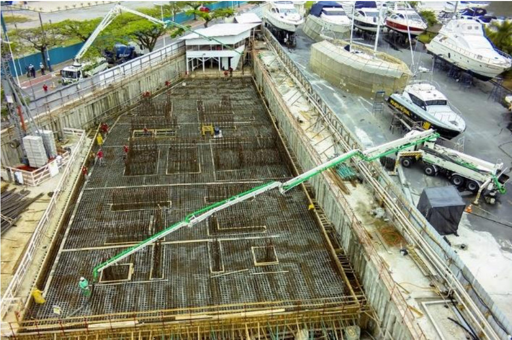
Edifício Yachthouse/SC, bloco de 4.600 m 3 (1300 m 2 x 3,5m) [81 andares e 275 metros de altura]
