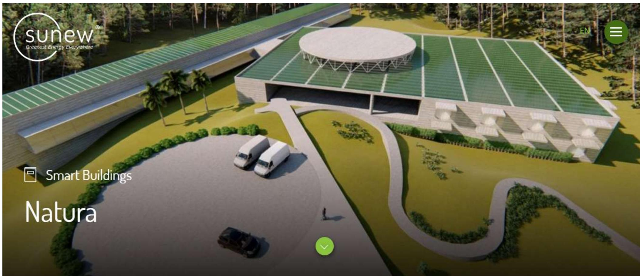
Instalação de 2 mil m<sup>2</sup> de painéis de Filmes Fotovoltaicos Orgânicos (OPV), terceira geração de células solares capazes de transformar a luz do sol em energia elétrica, na sede da Natura em Cajamar (SP).
