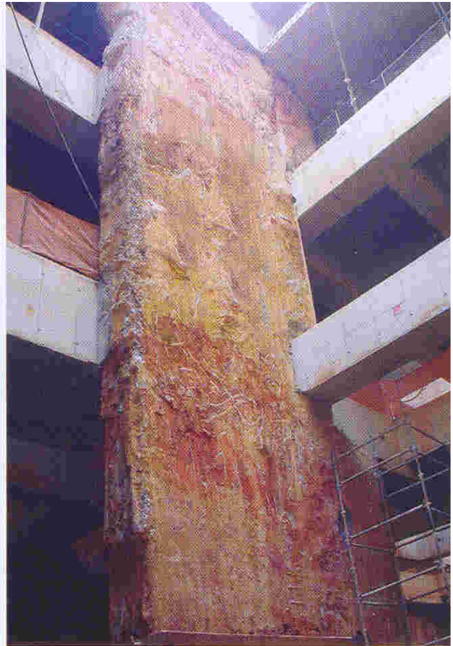
Estaca Barrete de 7,00 x 1,00 x 48,00 m de profundidade (funcionando também como pilar) - Metrô Linha 2 Estação Klabin - São Paulo / SP
