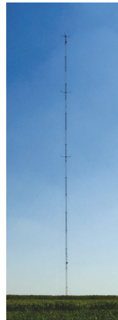
Torre de 100 m
