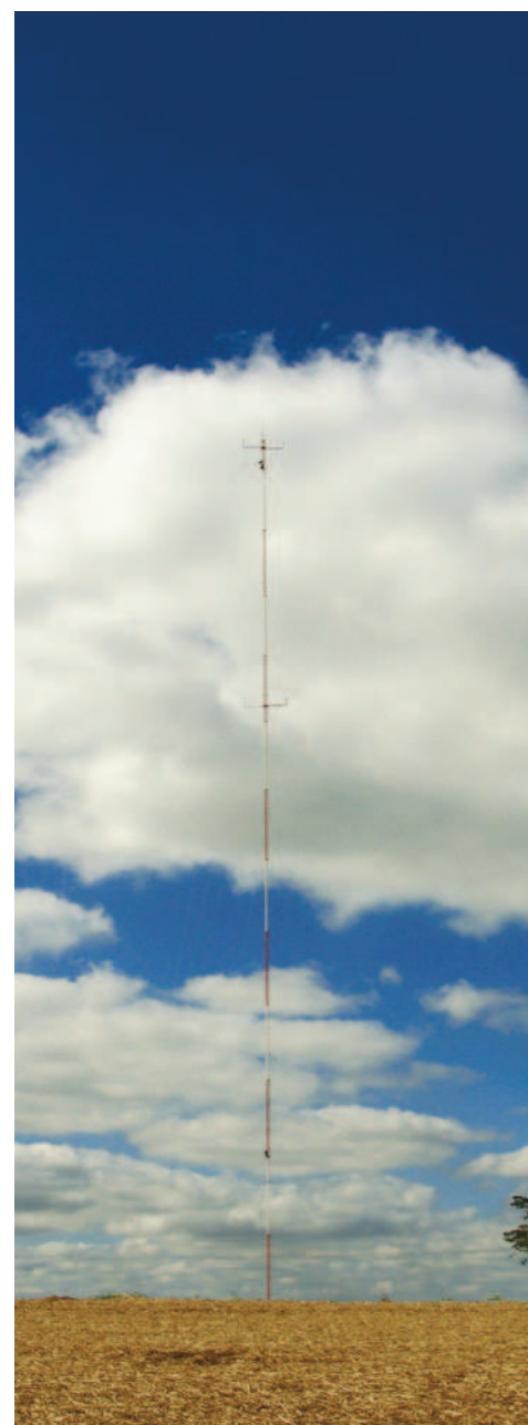
Torre de 75 m
