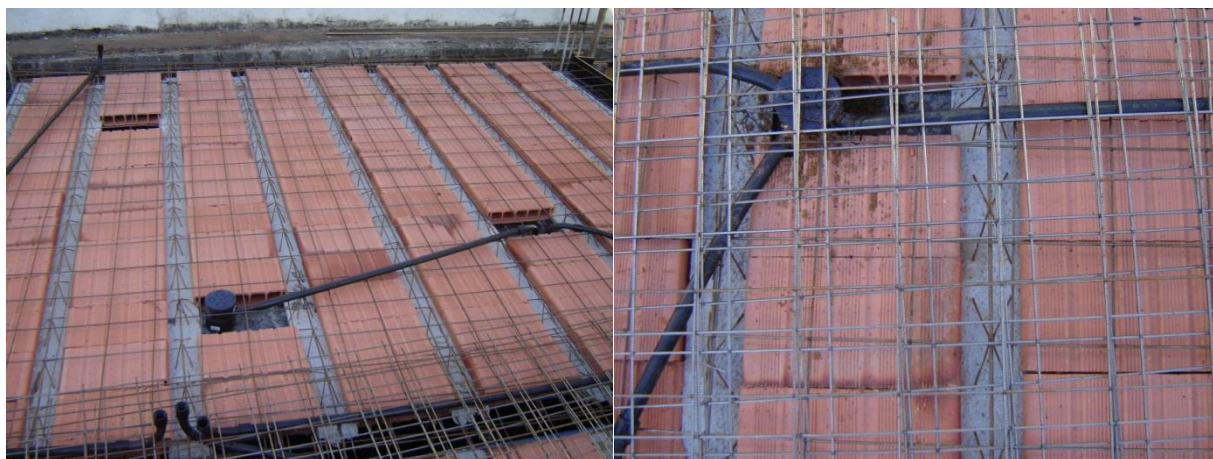
Figura 3 Vista geral da face superior da laje pré-moldada de forro com o posicionamento das caixas, dos eletrodutos e da armadura. Fonte: acervo da disciplina AUT0190.
