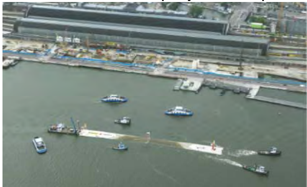
Transporte e posicionamento dos módulos
