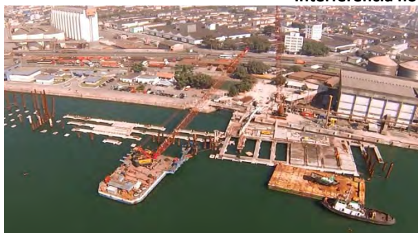
Situação das Obras em Julho/2013(DERSA)
