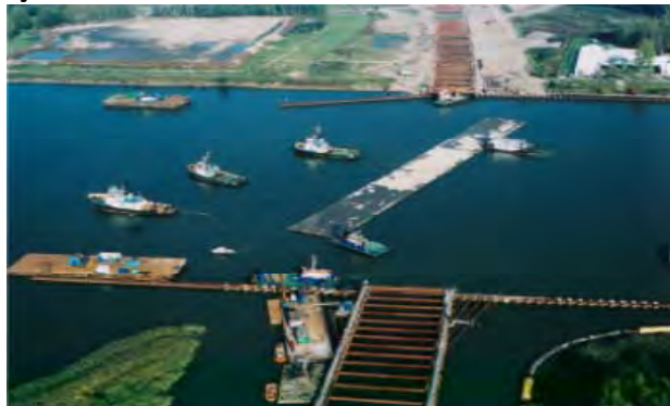
Transporte e posicionamento dos módulos
