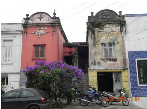
Localização e Foto de Moradias na Rua Santos Dumont (Santos)
