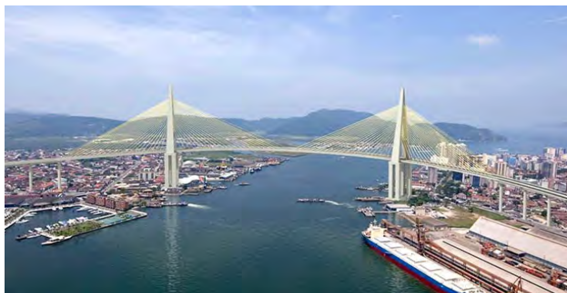
Ponte estaiada na Ponta da Praia
