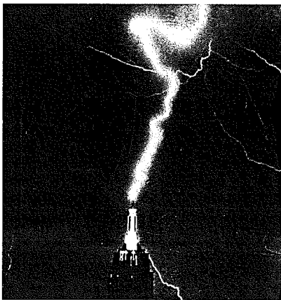
Figura 23.18 O mastro metálico no topo do Empire State Building atua como um pára-raios, sendo atingido por raios mais de 500 vezes por ano.
