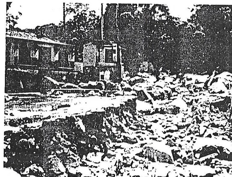
Figura 3.4 — Porção inferior de um movimento de massa na forma de corrida, ocorrido em fevereiro de 1996, nas proximidades do Largo do Anil, Jacarepaguá (RJ). Vários dias chuvosos, com índices pluviométricos alcançando cerca de 300mm em 24hs, foram suficientes para deflagrar uma série de escorregamentos nas cabeceiras dessa drenagem (veja Figura 3.9), os quais alimentaram o poder de destruição do fluxo.
