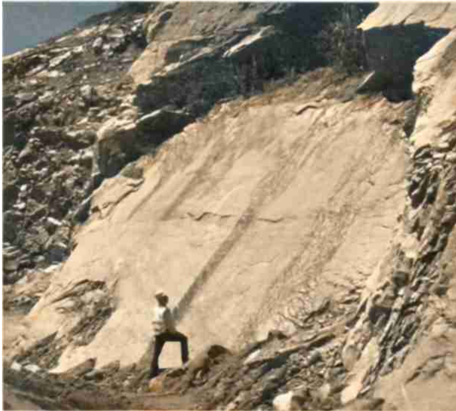
Ruptura de Talude de Mineração
