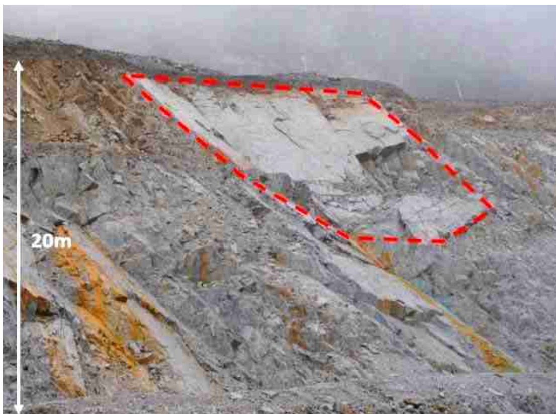
Ruptura de Talude de Mineração
