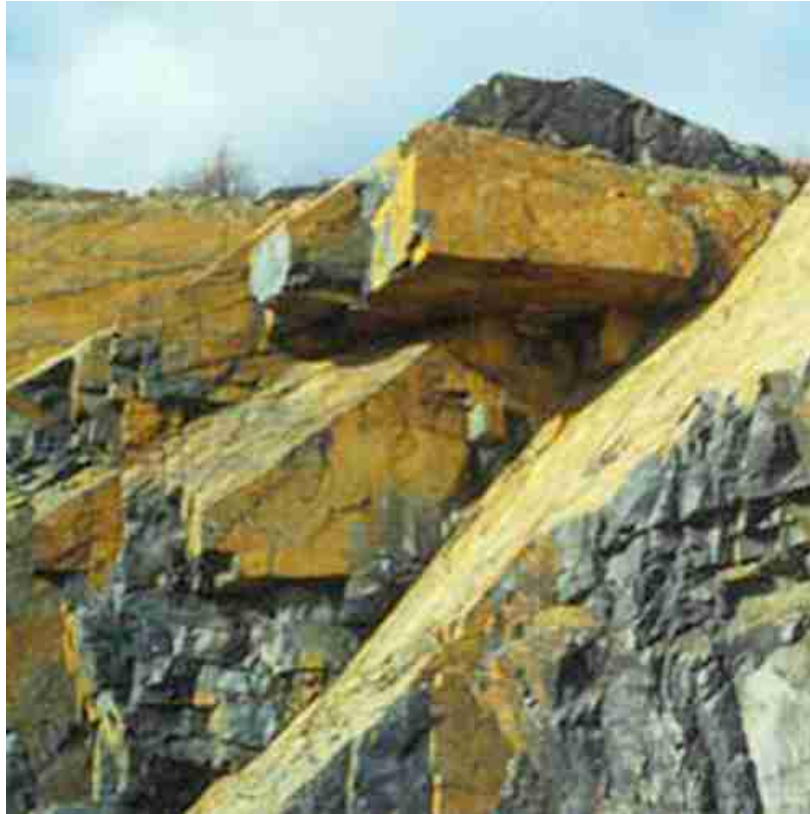
Ruptura de Talude de Mineração
