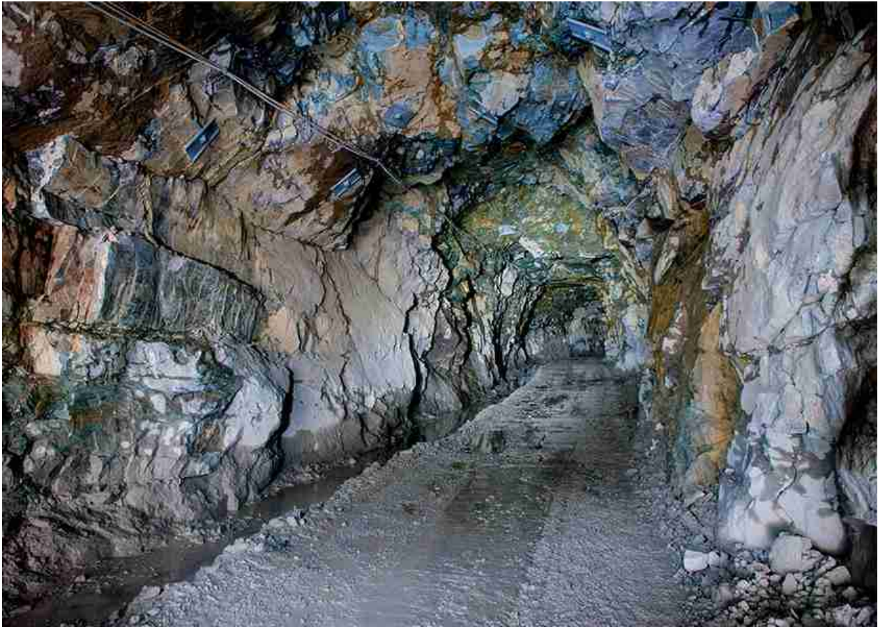
Túnel com faces irregulares em função do fraturamento da rocha
