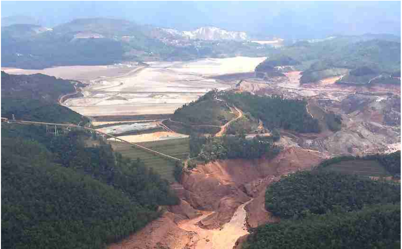
Rompimento da barragem do Fundão
