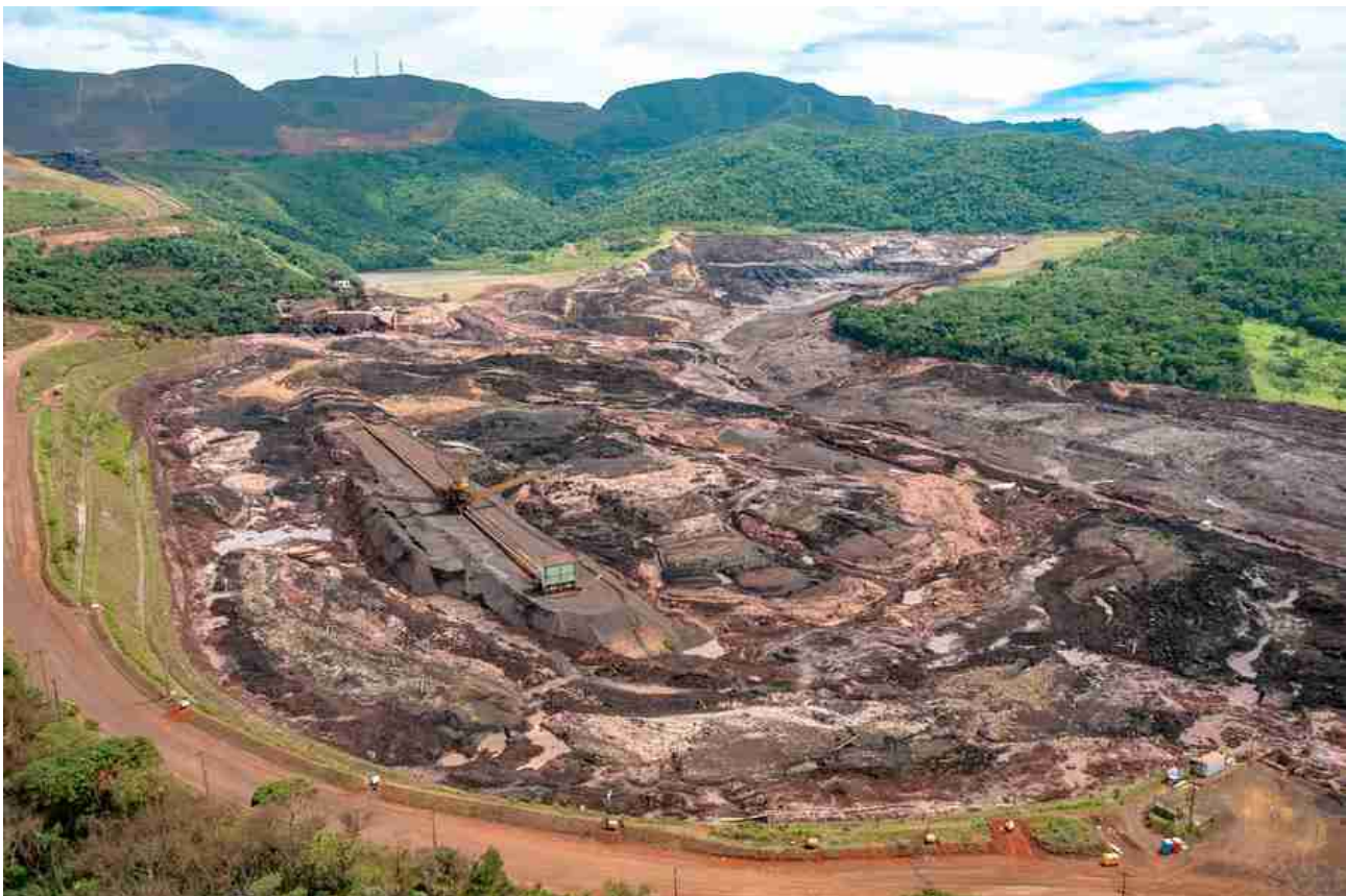
Barragem e área de estocagem de minério após o rompimento
