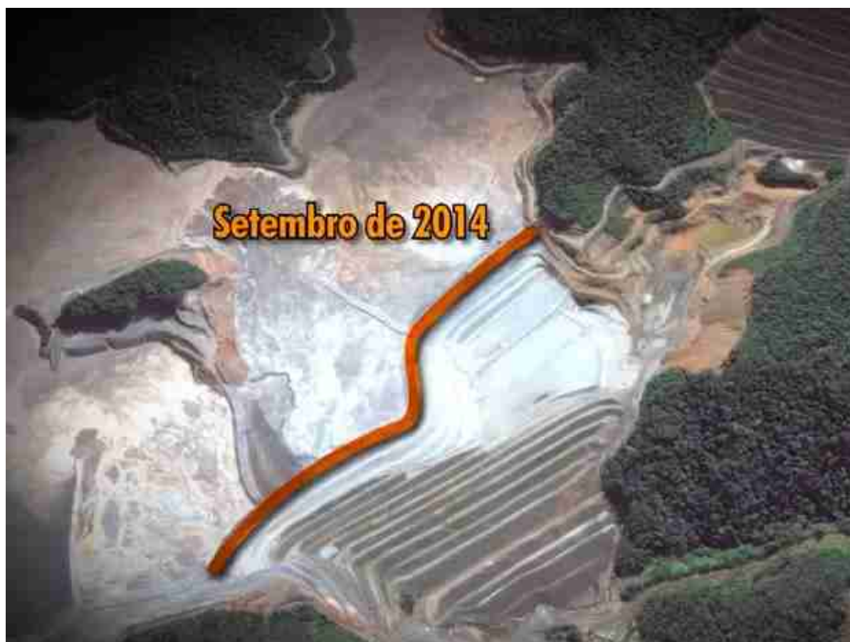
Alteamento da barragem
