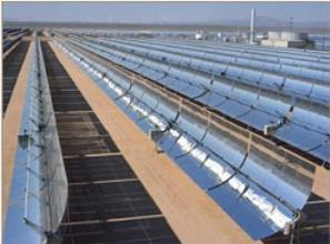
**Usina heliotérmica** a base de calhas cilindro-parabólicas.
