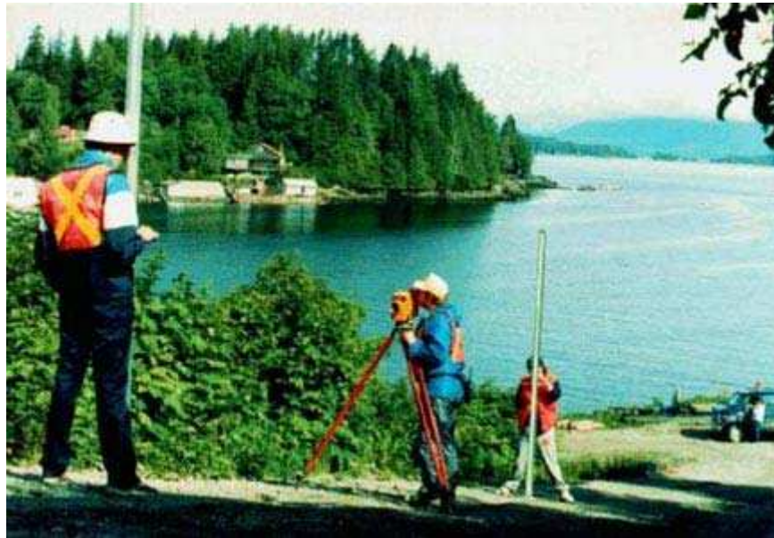
Figura 6.3 – Realização de um Nivelamento Geométrico
