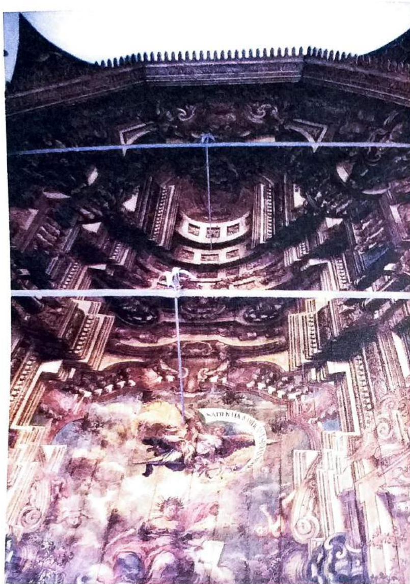
Teto da biblioteca do colégio dos jesuítas em Salvador.
