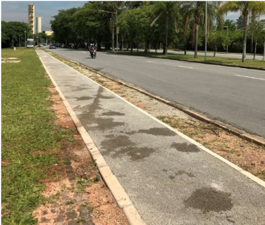
TRECHO 1 ESTRUTURA DO LMP PERVIOUS – REGIÃO C/ MANTA PERMEÁVEL
