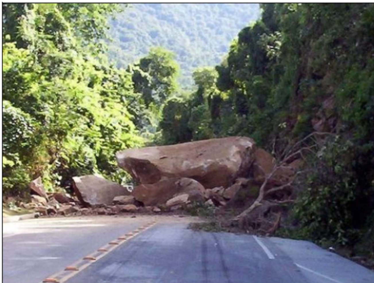
Figura 14: Deslizamento de pedras interdita a Rio-Santos, na altura de Conceição do Jacareí na região de Angra dos Reis.
