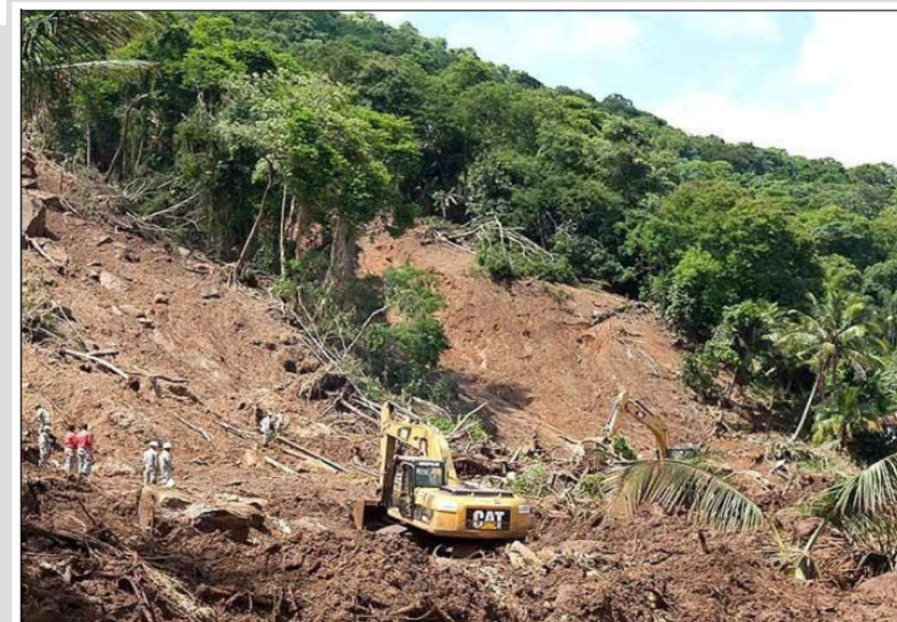
Figura 9: Deslizamento de terra nas encostas da região de Angra dos Reis Fonte: Foto da AP-Associated Press; 02/01/2010.
