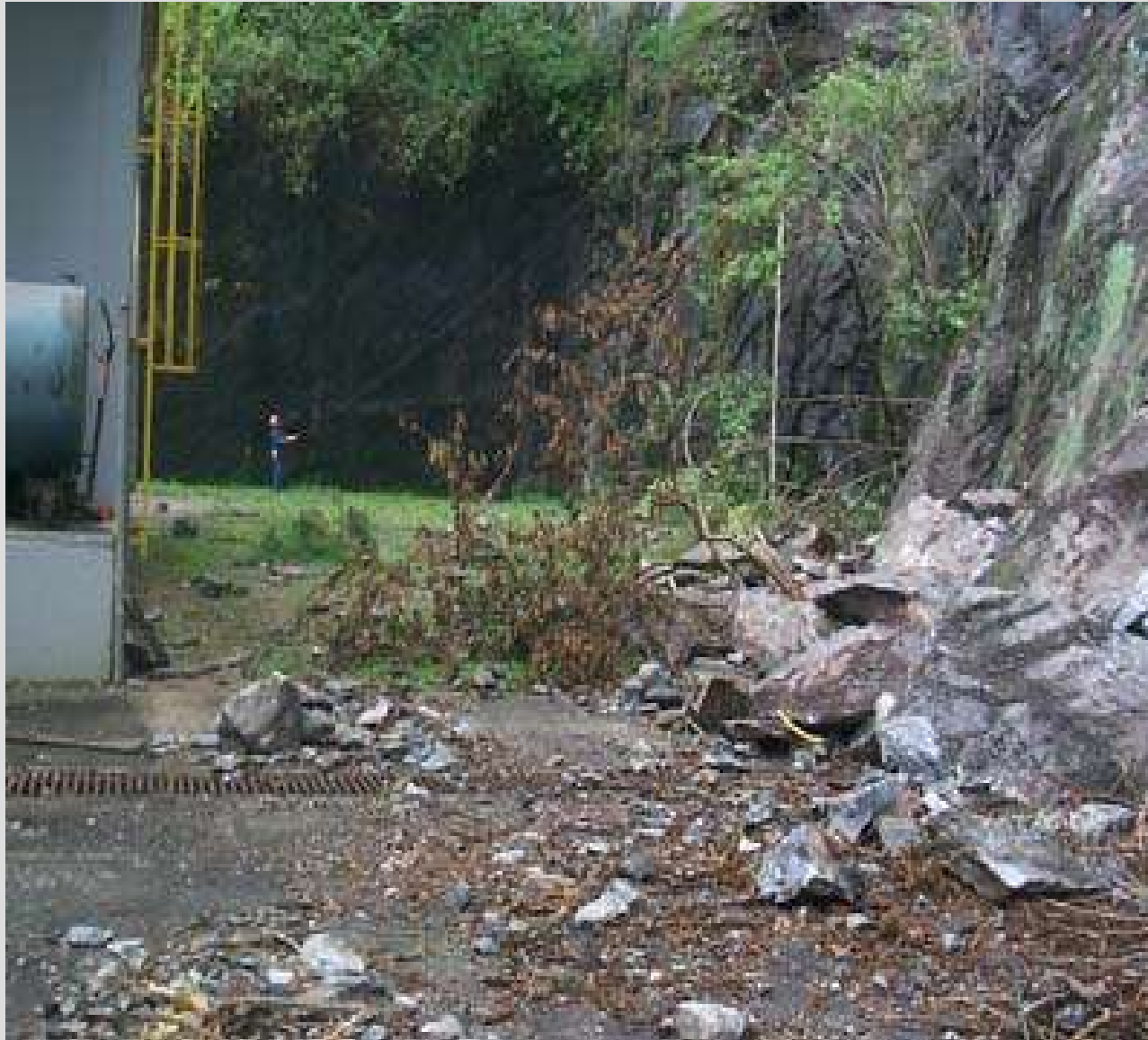
“Depósito” de Rejeitos Radioativos - Angra dos Reis
