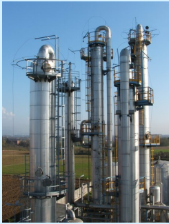
Exemplo de colunas de destilação fracionada empregadas em escala industrial
