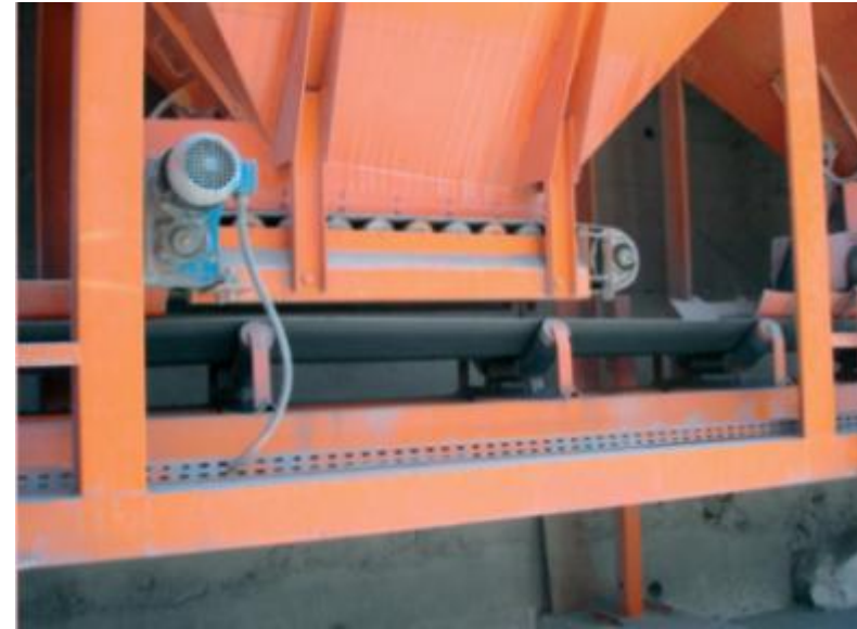
CONTROLE NO FUNDO DOS SILOS FRIOS
