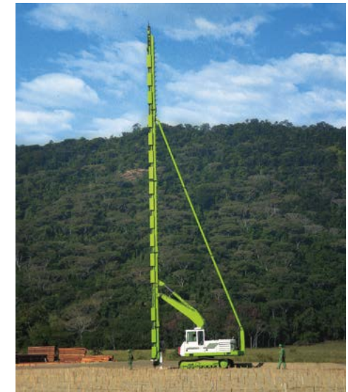
Figura 4 - Equipamento em serviço de cravação de geodrenos.
