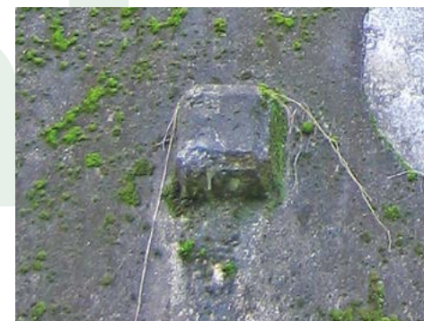
Figura 12 - Fluxo de água na cabeça do tirante.
