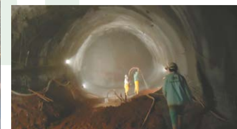
Figura 12 - Túnel de interligação entre edifícios.
