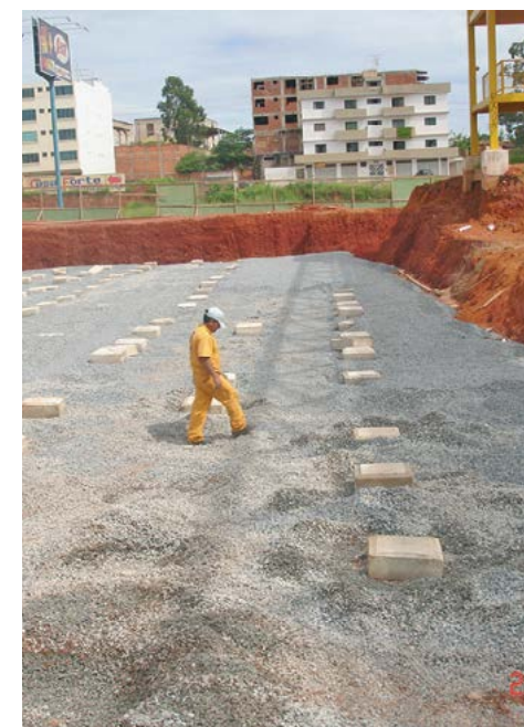
Figura 11- Lançamento da camada de brita entre as estacas, já com os capitéis.
