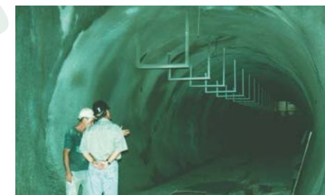
Figura 11 - Túnel industrial para serviços industriais, com 5,16m de diâmetro.
