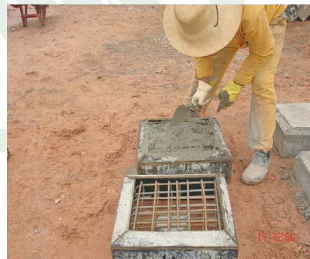
Figura 10- Execução de capitel para SS Anchor, no local da obra.
