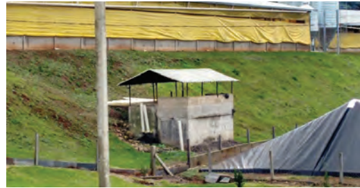
FOTO 03 | Pavilhão de recria com sistema de captação e sistema de filtragem da água da chuva.
