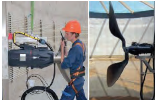
FIGURA 13 | Instalação dos agitadores submersos.
