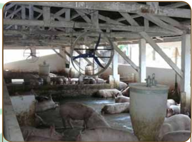
Figura 7: Ventiladores e umidificadores para o verão.
