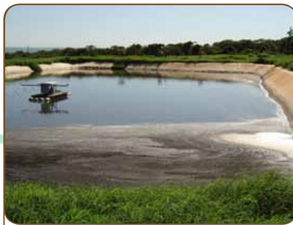
Figura 6: Lagoa de estabilização.
