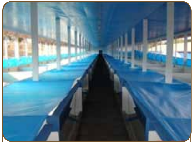
Figura 6: Cortinas, forro e abafadores para aquecer no inverno.
