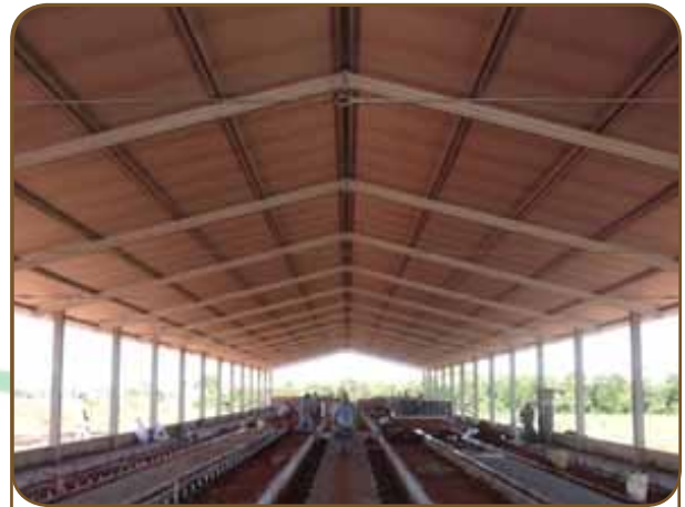
Figura 8: Telhas térmicas (poliestireno).
