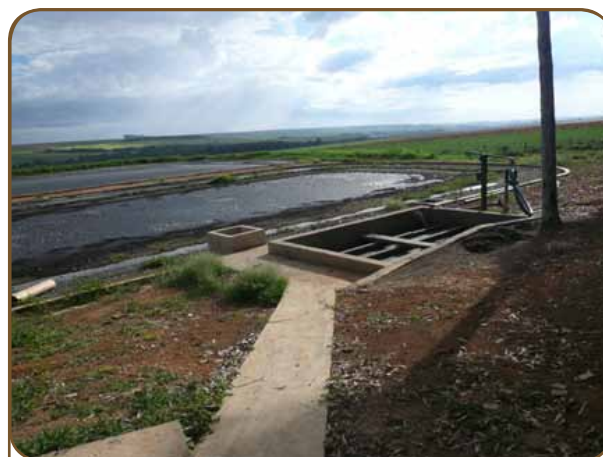
Figura 3: Decantador de dejetos, com lagoas de estabilização ao fundo.
