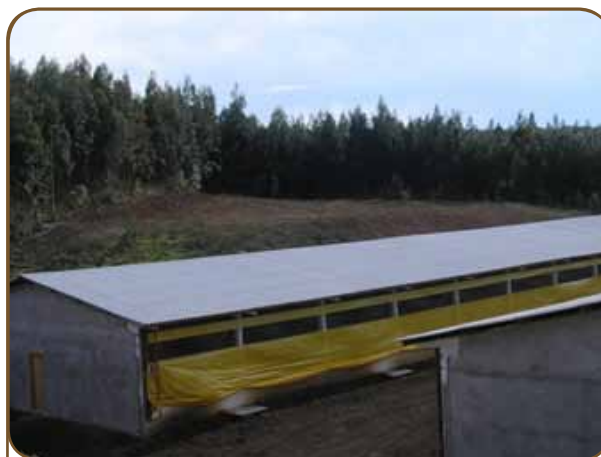
Figura 7: Telhas de fibrocimento.
