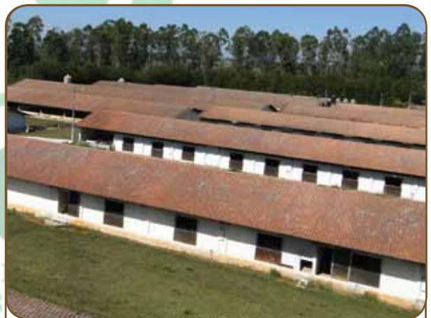
Figura 9: Telhas de barro.
