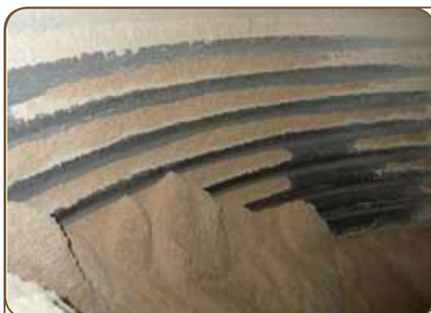
Figuras 23 e 24: Parte superior do silo suja.
