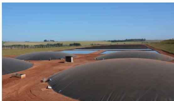
Foto 10. Biodigestor do tipo lagoa coberta
