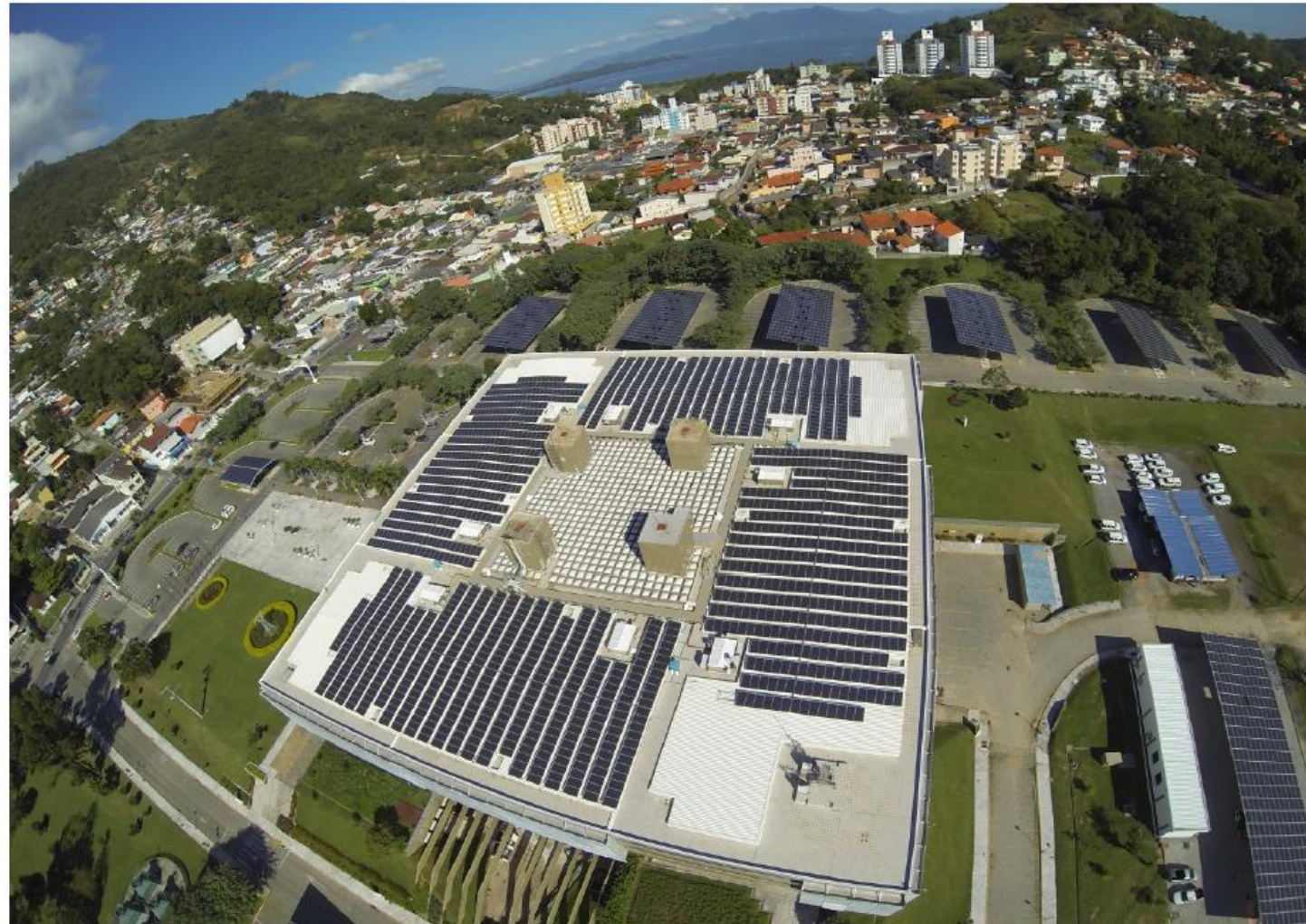
Megawatt Solar: 1,1 MWp instalado sobre a cobertura do Edifício Sede da Eletrosul e de estacionamentos, instalado na cidade de Florianópolis, SC (UFSC;2014).
