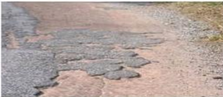
Foto 17 - Desgaste do revestimento nas curvas
