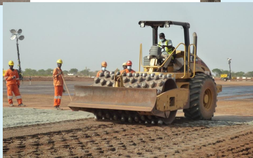
Compactação após mistura
