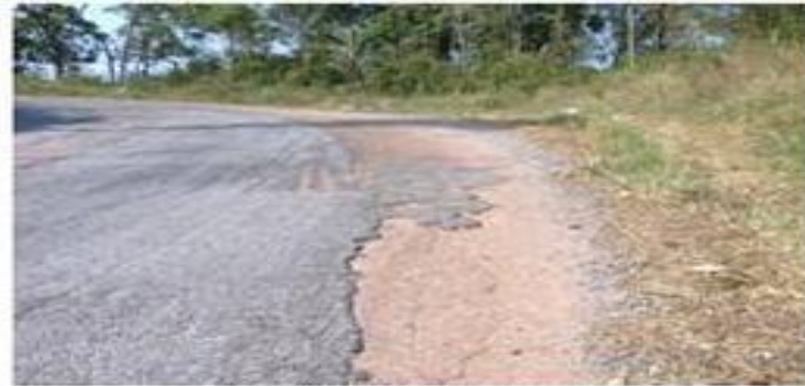
Foto 18 - Desgaste do revestimento nas curvas
