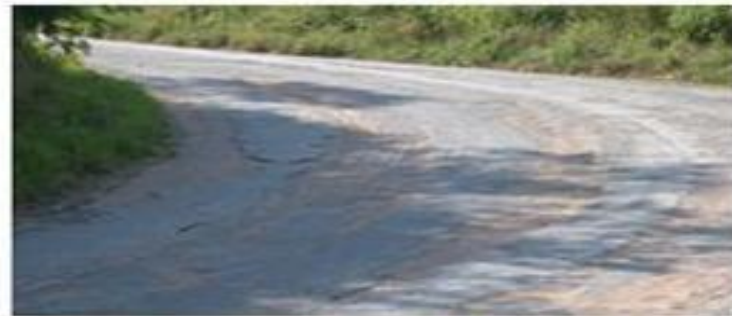
Foto 18 - Desgaste do revestimento nas curvas
