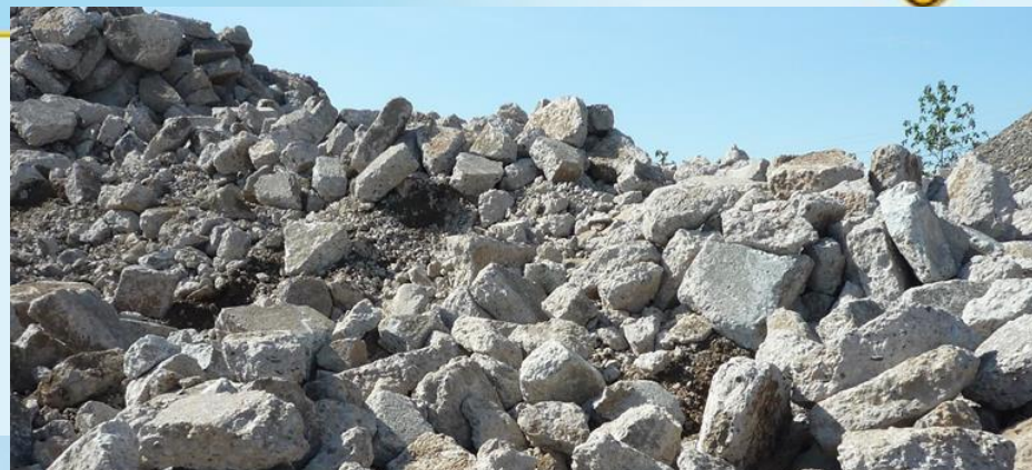
Resíduo de placas de concreto
