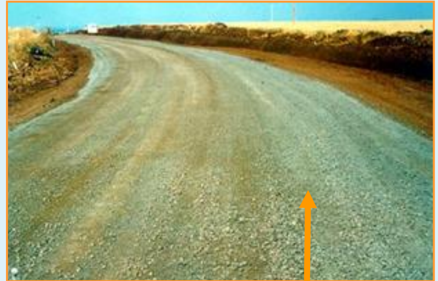
Bica corrida (material granular similar à BGS, com menor controle de gradação)
