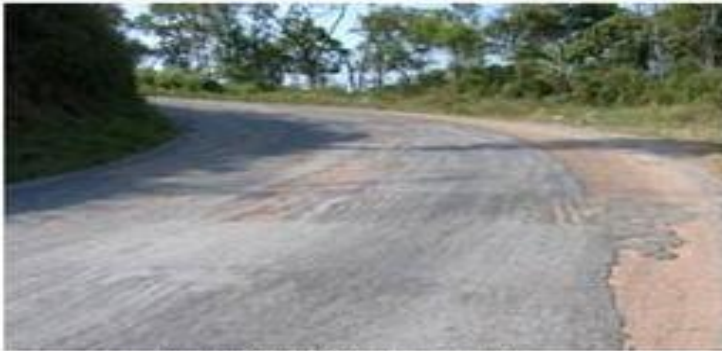
Foto 17 - Desgaste do revestimento nas curvas
