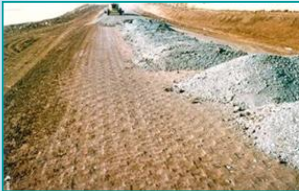
Pilhas de britas para serem adicionadas a solo em pista
