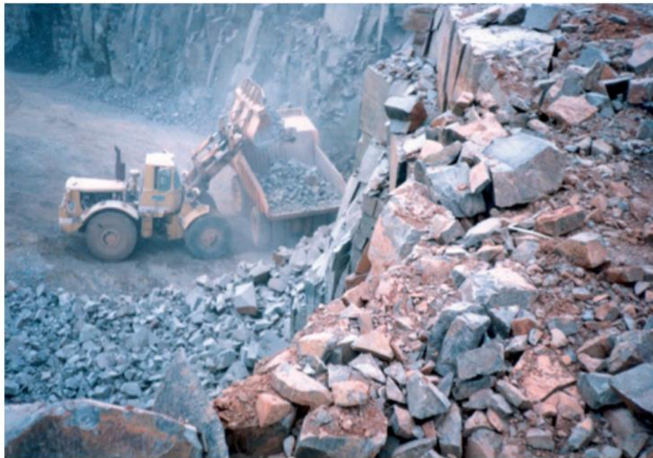
Figura 3.4 Carregamento de um caminhão na pedreira
