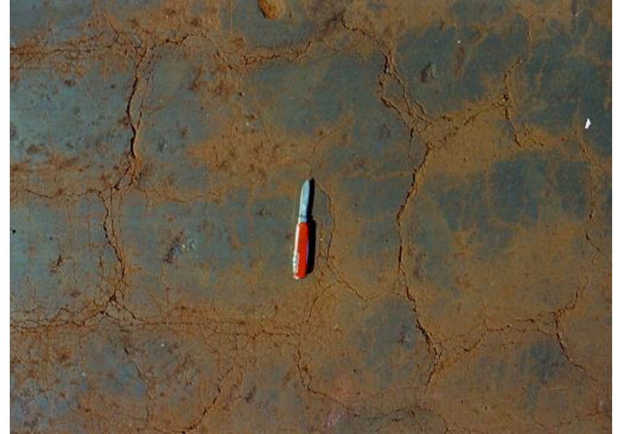
Areia argilosa laterítica compactada TRINCADA após perda de umidade
