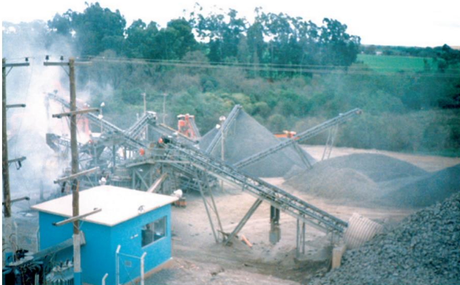
Figura 3.6 Vista geral de uma instalação de britagem
