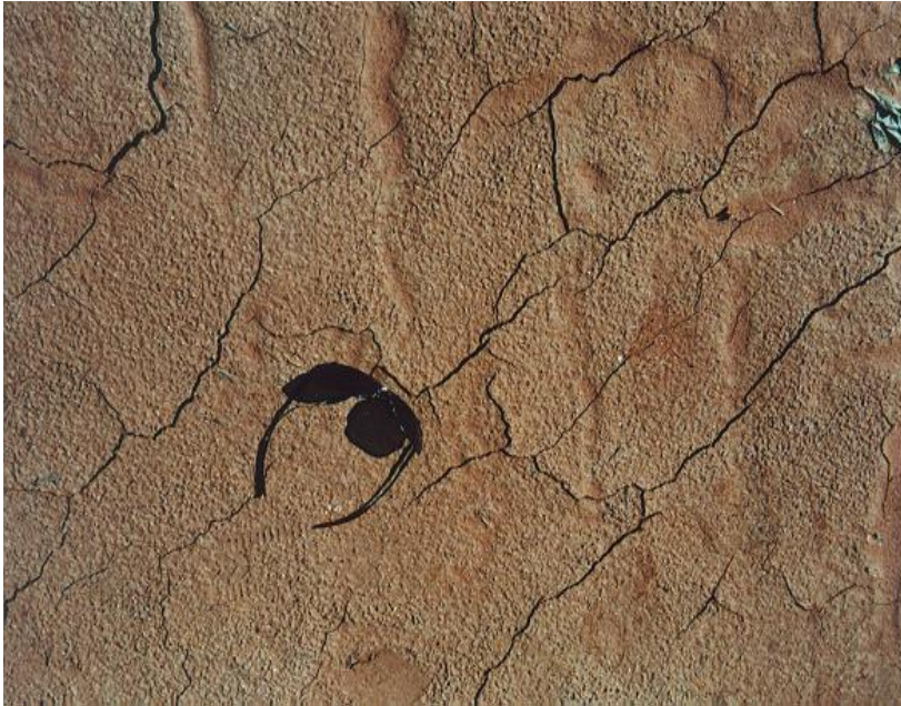
Solo saprolítico compactado trincado após expansão
