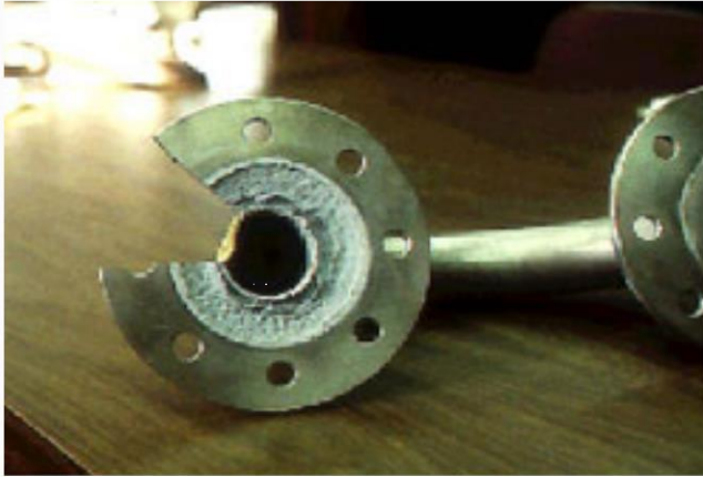
Corrosão em fresta em flange de liga de Ti-4Va 6Al
