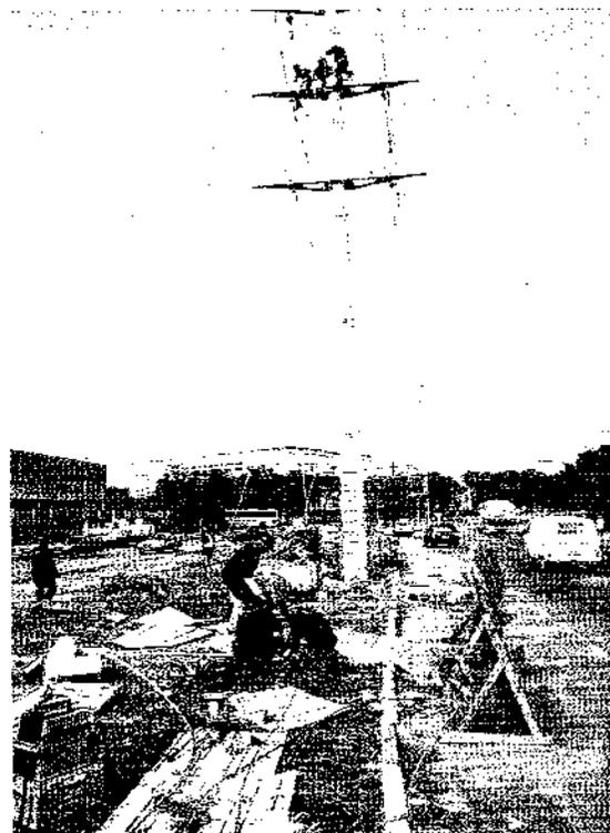
**Fig. 8.2** Construção de uma linha de transmissão de energia elétrica em área urbana. O estudo dos métodos e processos construtivos é uma das principais tarefas para a identificação dos impactos ambientais. Nesta foto, está em execução a instalação dos cabos e dos isoladores
