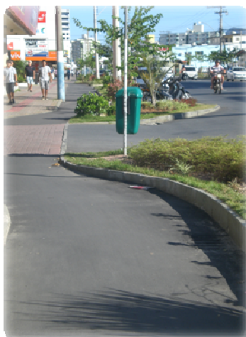
Trecho 07- 5ª avenida esquina com Rua Dom Felipe
