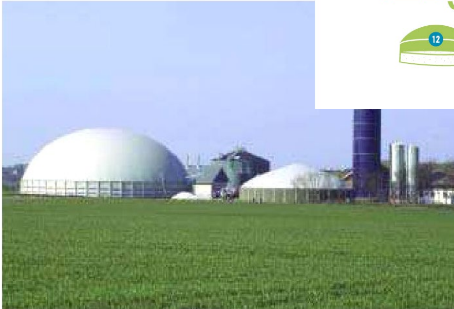
Planta de co-digestão anaeróbica - Dinamarca
