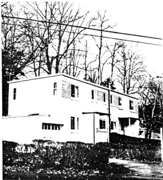
Cidade nova de Greenbelt, Maryland. A escola.
