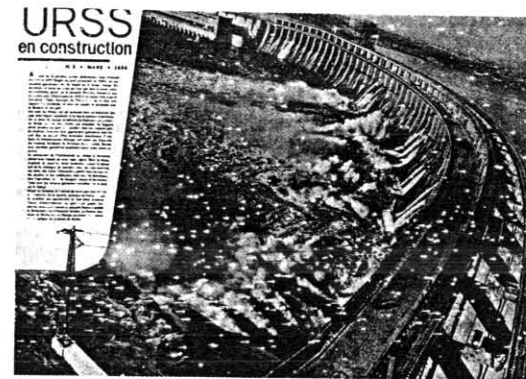
O canteiro de obras da grande barragem sobre o Don: o Dnieprostroi (uma vez terminada Dnieprogues), na época a maior barragem do mundo, foi o símbolo do plano quinquenal e da passagem da URSS à categoria de país industrializado.
