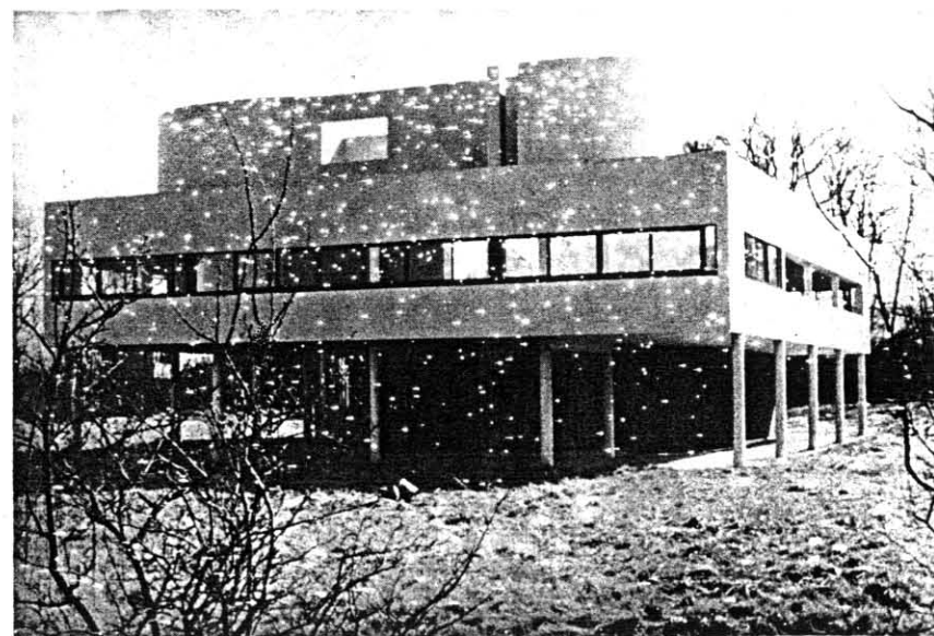
A vila Savoye em Poissy, 1929/1930. Uma experiência de aplicação dos “5 princípios” de Le Corbusier: plano livre, fachada livre, janelas em toda a extensão, pilotis, telhado-terraçado.
