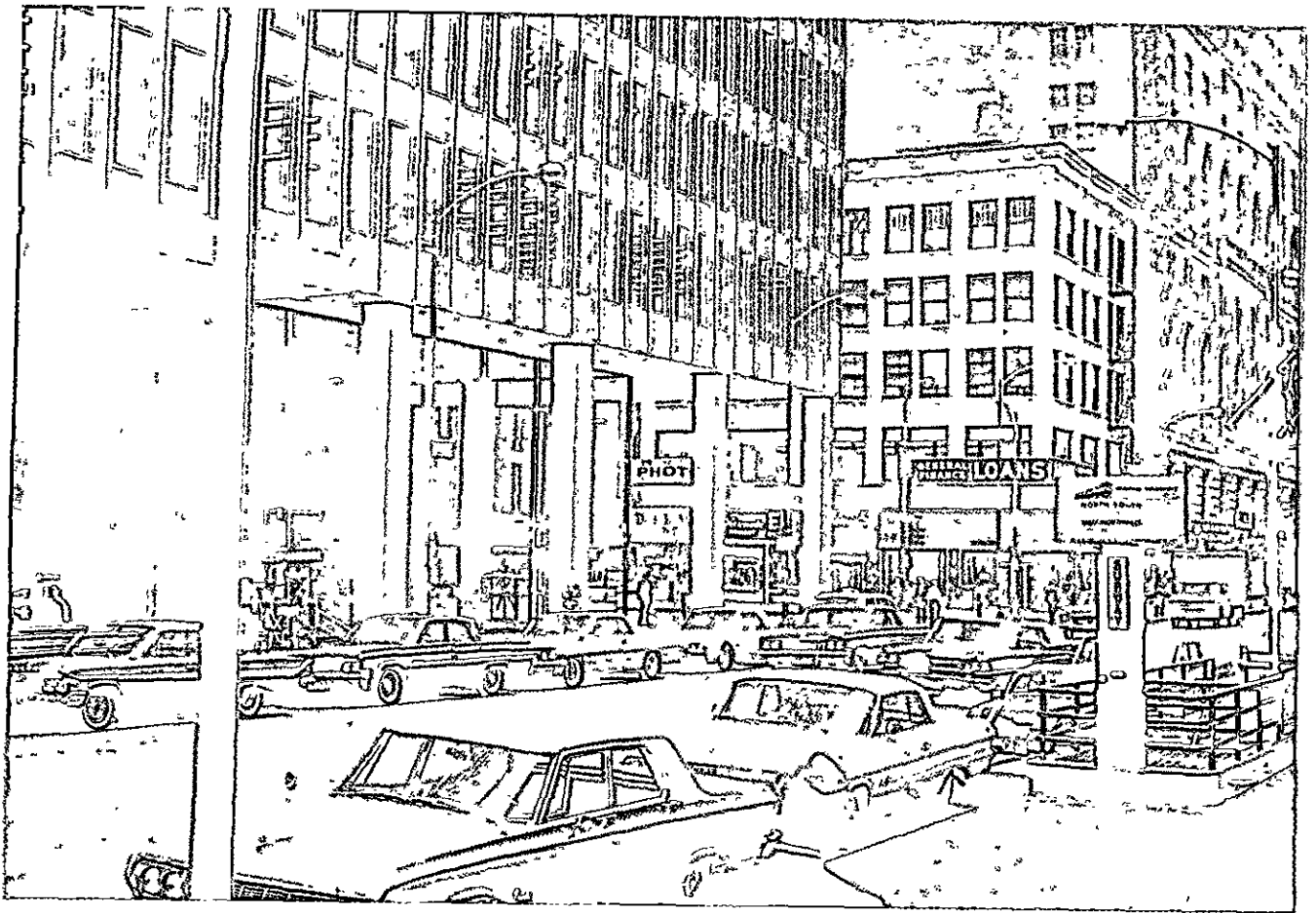
1011, 1012, 1013. Chicago, o Federal Center com o edifício da Corte Federal de Justiça (Mies van der Rohe, 1960).
