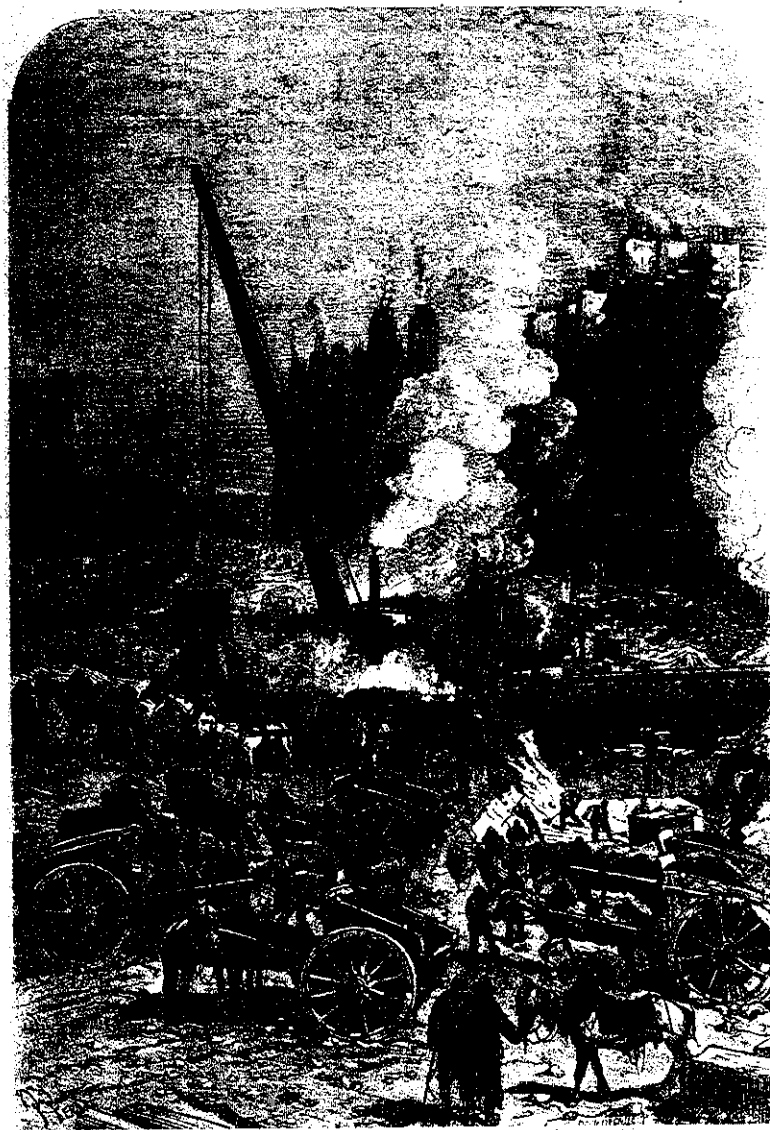
Demolições para a abertura da Av. de l'Opéra. Gravura de Ferat
