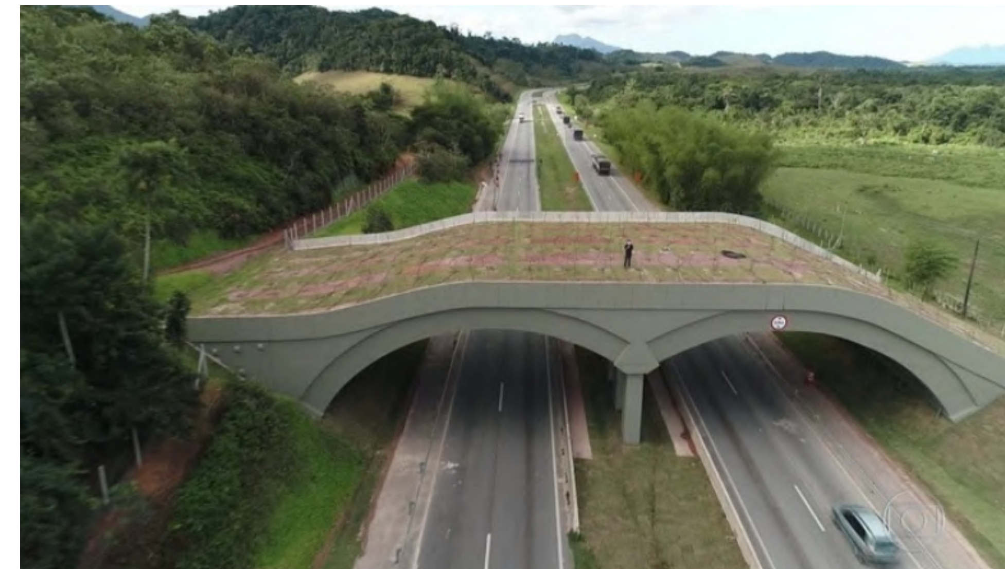
Legenda: Viaduto verde implantado no Estado do Rio de Janeiro, conectando a Reserva Biológica de Poço das Antas com a fazenda Igarapé. Fonte: G1
