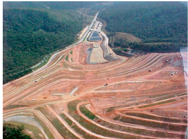
Aterro São João (Distrito de Iguatemi - São Mateus) (Foto: Acervo SVMA)
