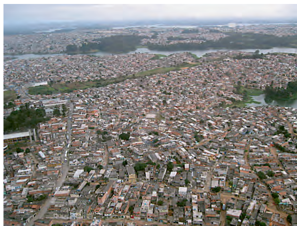
Ocupação irregular em área de mananciais - Distrito Grajaú - Zona Sul (Foto: Acervo DUC/SVMA)
