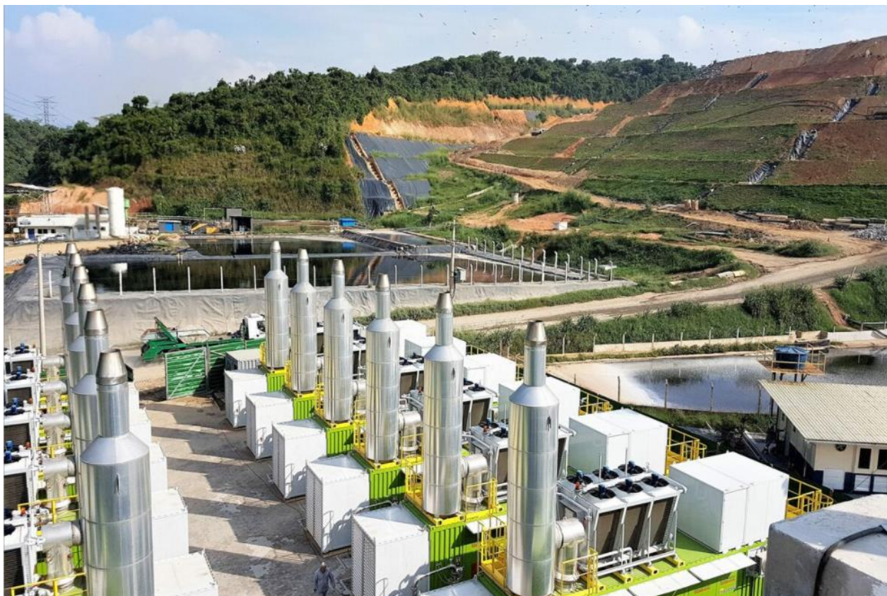
Fig. 1.4 - Imagem de uma usina termelétrica a biogás, na cidade de Caieiras/SP.
