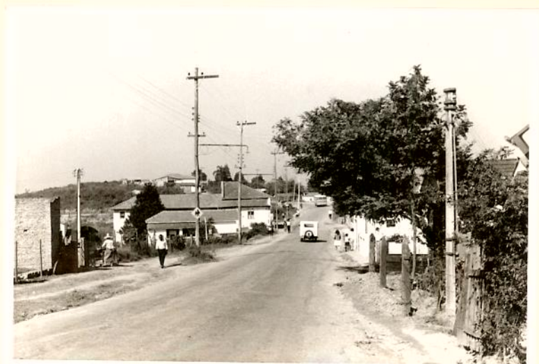
Estrada que liga Aldeia de Carapicuíba a Carapicuíba . Trata-se de cixo de desenvolvimento suburbano notabilizado por sua disposição transversal, perpendicular ao eixo principal, representado localmente pela Sorocabana (foto do autor).
