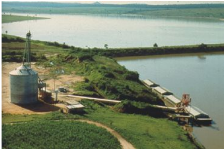
Terminal Santa Maria da Serra - SP
