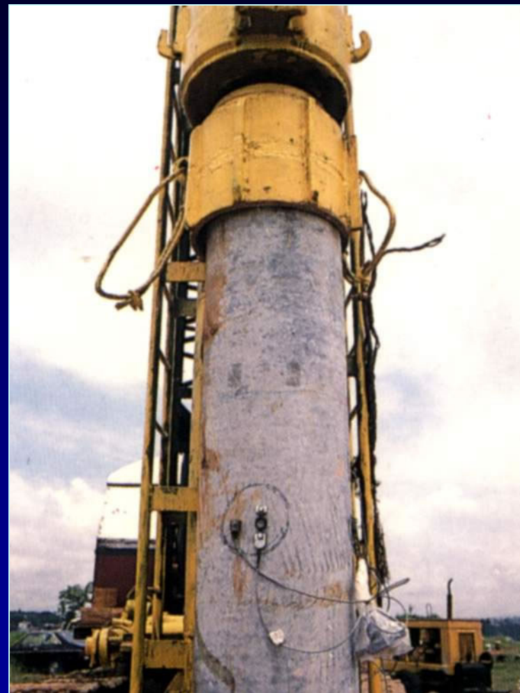
Instrumentos instalados numa estaca pré-moldada de concreto
