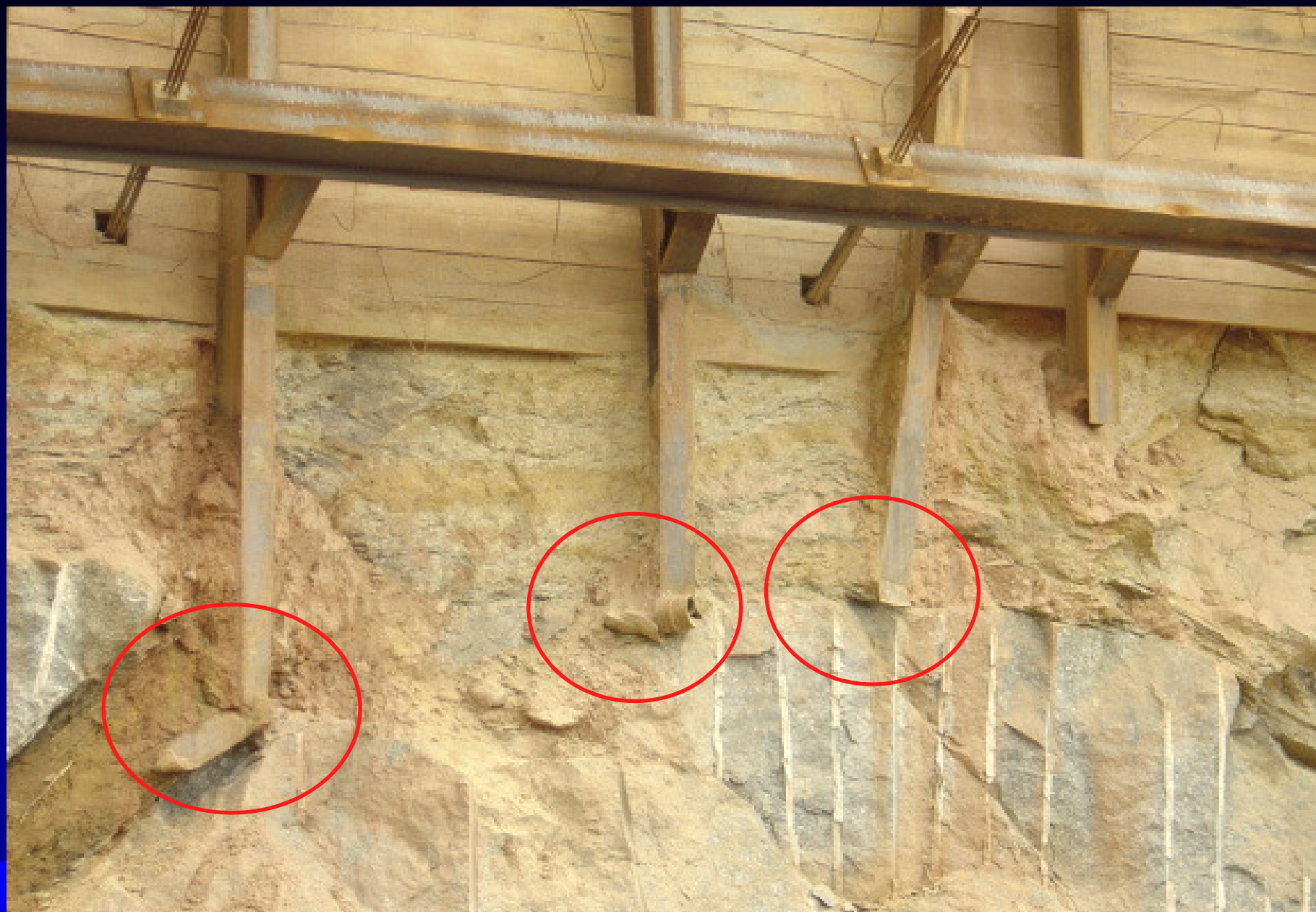
Situação dos perfis metálicos ao atingirem o topo rochoso
