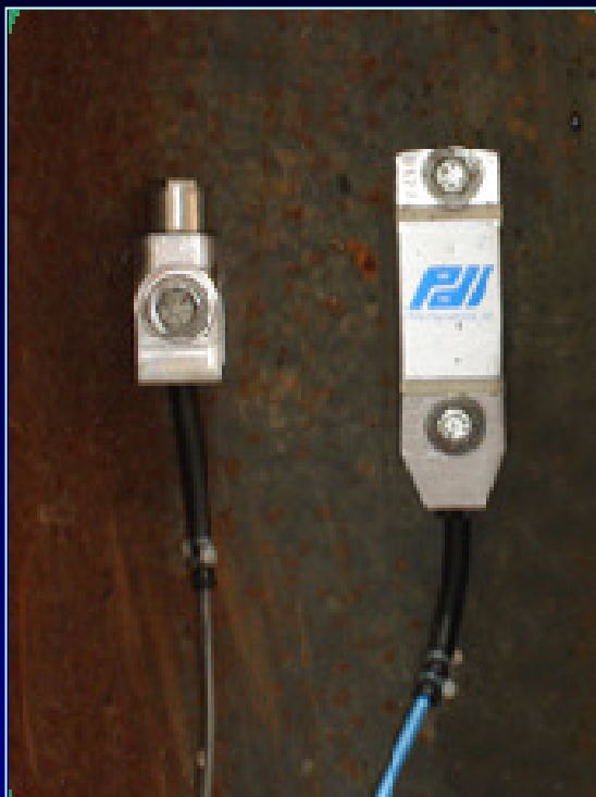
Transdutores de deformação e acelerômetro instalados na estaca.
