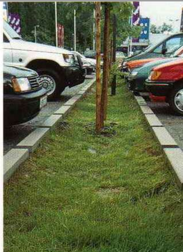
Vala gramada entre as vagas de estacionamento
