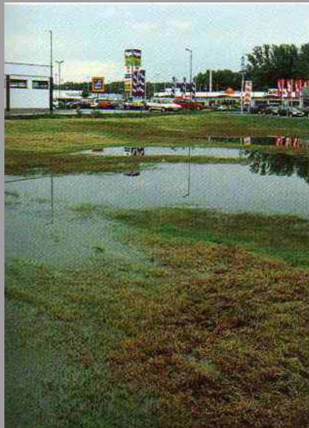
Bacia de retenção com a água infiltrando após chuva forte
