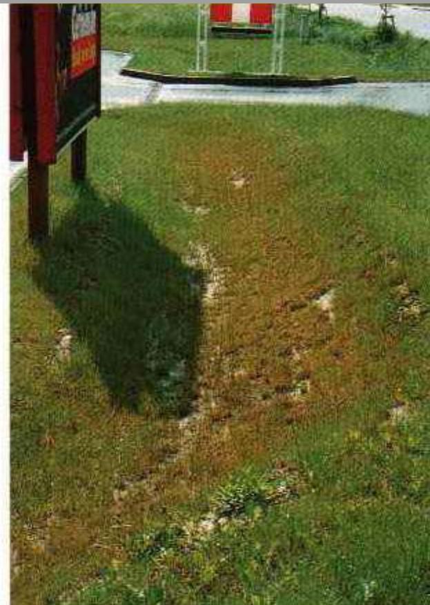
Valas vegetadas com alto potencial de purificação
