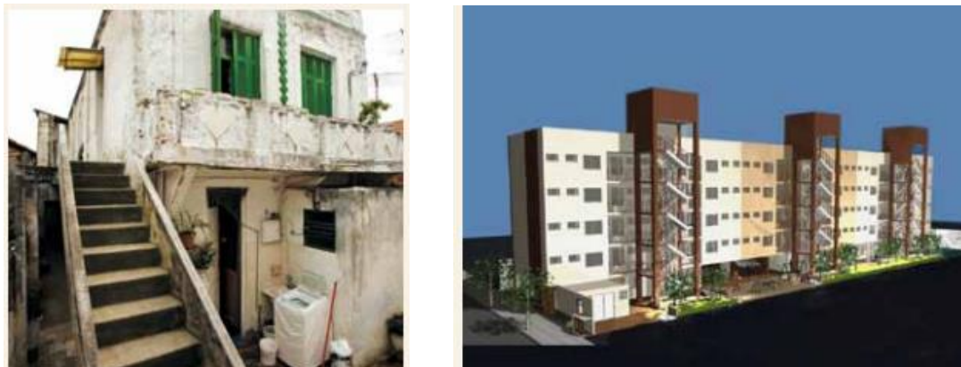
FIGURA 6 > Cortiço localizado na rua Celso Garcia, bairro Belém; projeto para 53 apartamentos
