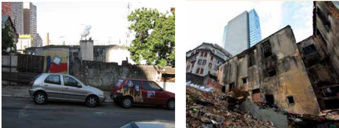
FIGURA 8 > Fotos do Local e Planta do Pavimento Tipo - Projeto CDHU - R. Tomás de Lima, 85
