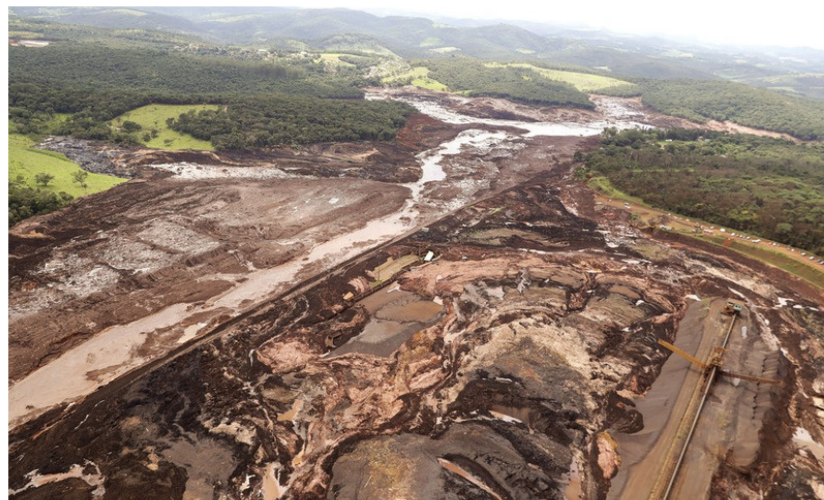
(Vista aérea da destruição causada pelo rompimento da barragem da Vale em Brumadinho. — Foto: André Penner/AP)
