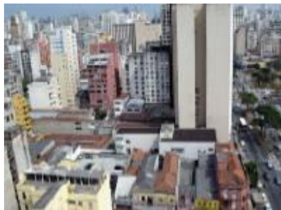
Figura 2 - Vista aérea do interior de uma das quadras da área, mostrando a escassez de espaços abertos e áreas verdes.
