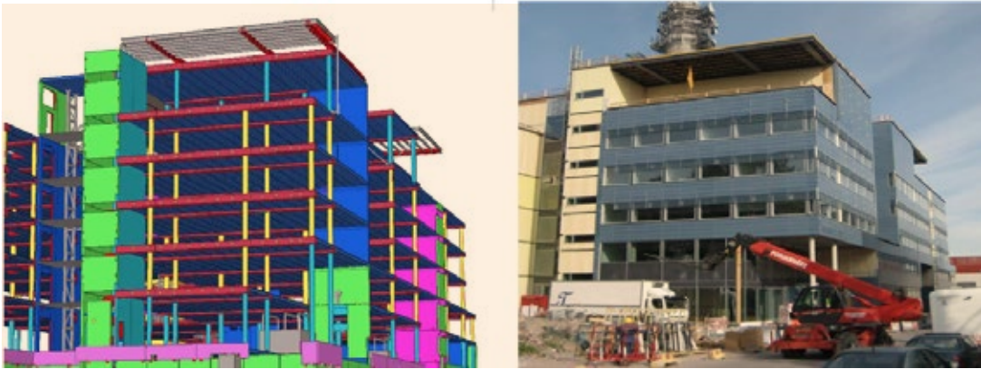
Figura 34: A figura da esquerda mostra uma vista renderizada de parte do modelo estrutural BIM de uma edificação, enquanto a da direita documenta uma das fases de construção, num ângulo bem semelhante ao utilizado para a criação da imagem. Em todo empreendimento construtivo, sempre existirá um subgrupo de informações que será importante para futuros processos de manutenção e gestão da edificação já concluída. Muitos softwares BIM exportam o subgrupo de informações no formato padronizado COBie, que é específico para o embasamento de processos de manutenção e gestão do ativo
