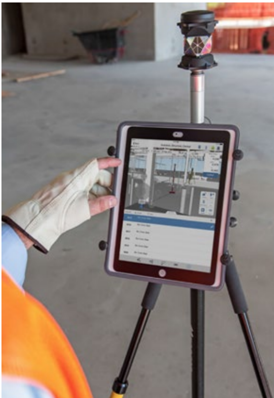
Figura 24: Estação total, usada na obra para retirar informações de um modelo BIM, e fazer, por exemplo, a locação de pendurais para sustentação e fixação de tubulações para ar condicionado. Além da locação de componentes e subsistemas, ela pode verificar desvios de nível e prumo nas partes já construídas
