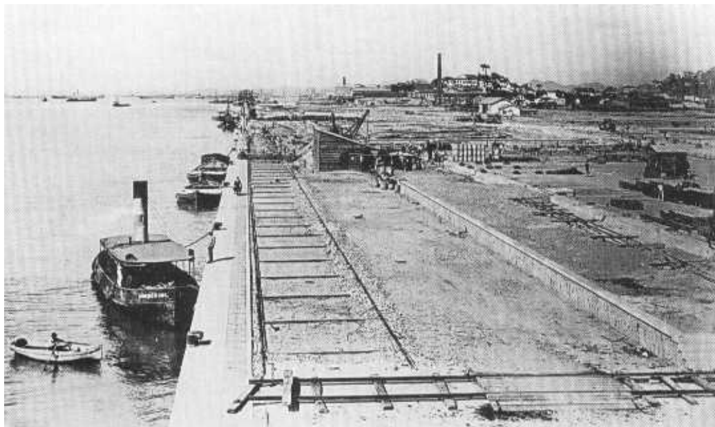
Figura 5 – Obras do aterro na região portuária
