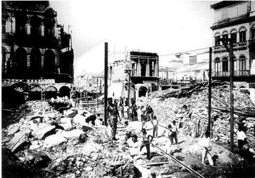
Figura 1 – Obras de Abertura da Avenida Central
