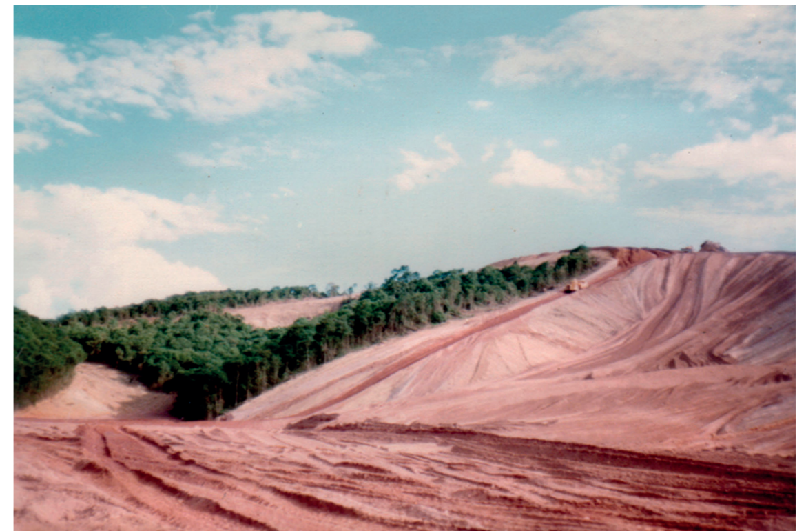
Imagem 11 – Gleba Santa Etelvina, no início dos anos de 1980, em obras de terraplanagem para implantação de conjuntos habitacionais da COHAB-SP
