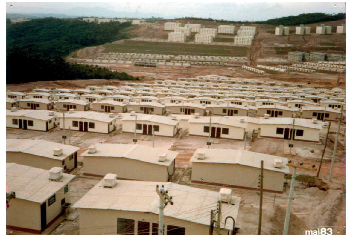
Imagem 12 – Gleba Santa Etelvina, em 1983, obras de implantação de conjuntos habitacionais da COHAB-SP
