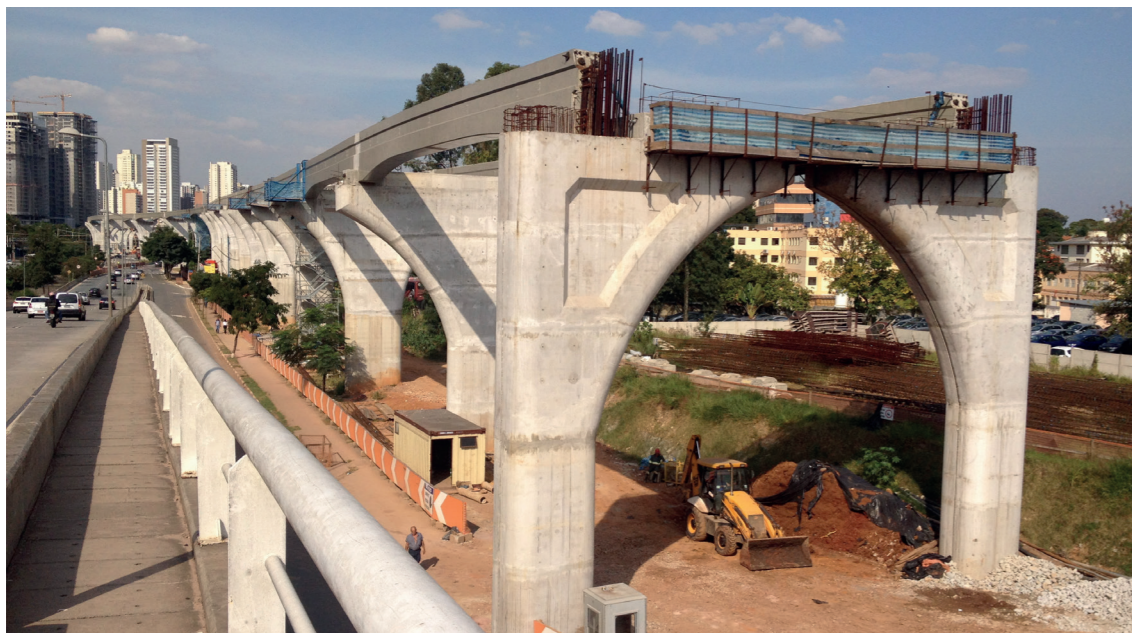
Imagem 3 – Obras do monotrilho na Avenida Roberto Marinho, antiga Águas Espreiadas
