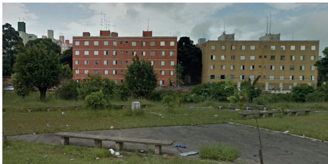
Imagem 2 – Empreendimento Minha Casa Minha Vida construído em terrenos remanescentes de conjuntos da COHAB-SP em Itaquera
