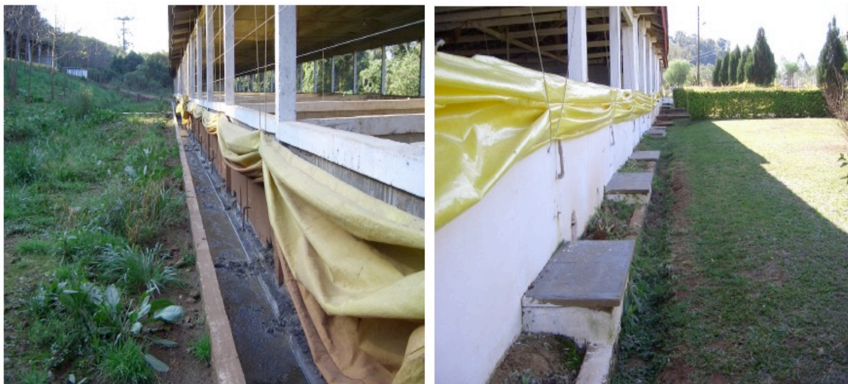
Fig. 5 - Foto da esquerda: Canal externo usado no manejo dos dejetos. Foto da direita: Implantação pelo PNMA II, de construção de canal externo coberto evitando-se a proliferação de moscas e de odores e infiltração da água da chuva.
