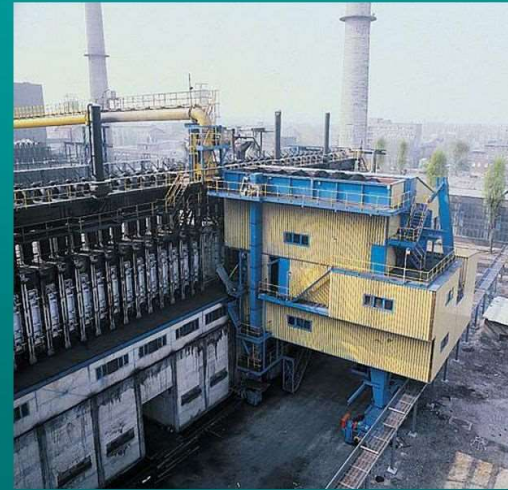
Bateria de Coqueificação
